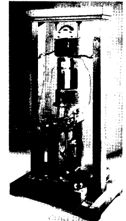
Einer der von Charles Wheatstone erbauten Dynamos. Im Jahre 1866 stellte er den ersten selbsterregten Dynamo der Fachwelt vor - im selben Jahr präsentierte auch Werner von Siemens diese Erfindung.
