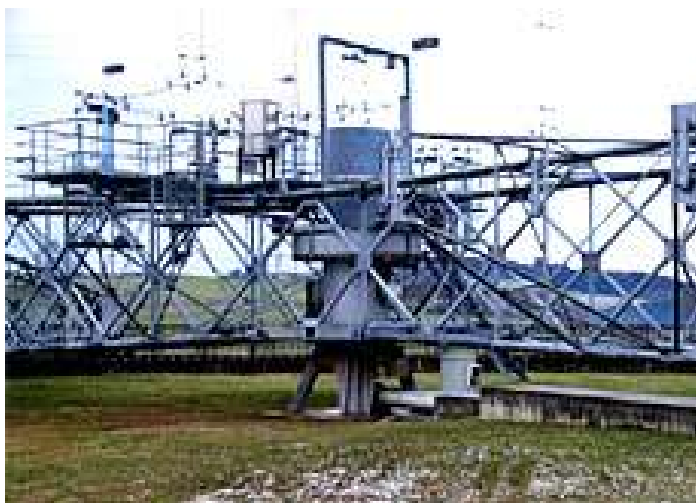
Abbildung 10: Drehstandantenne für den Überseedienst für den 500-kW-Sender in Sottens
