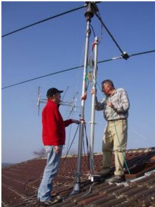
Als erstes galt es, die alte High Gain Antenne abzubauen. Der Ausdruck "Ersatz für Defekt" hat sich mehr als bewahrheitet. Sämtliche Spannbridgen waren verrostet und mussten gesprengt werden, zudem war auch ein Trap des Reflektors verbrannt. Ob als Folge von "High Power" oder Blitzschlag konnte nicht ermittelt werden. Der Rotor ist "noch" betriebstauglich, weist aber auch Schäden des Alters auf.
