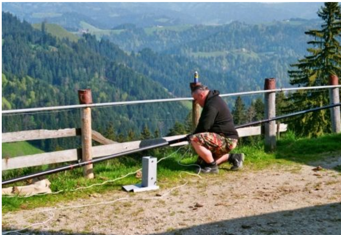
Der Mast für die Longwire wird zum Aufstellen vorbereitet. Die LW wird in die Umlenkrolle eingefädelt
