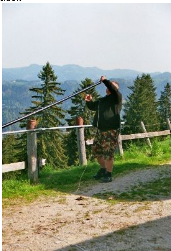
Der Mast für die Longwire wird zum Aufstellen vorbereitet. Die LW wird in die Umlenkrolle eingefädelt
