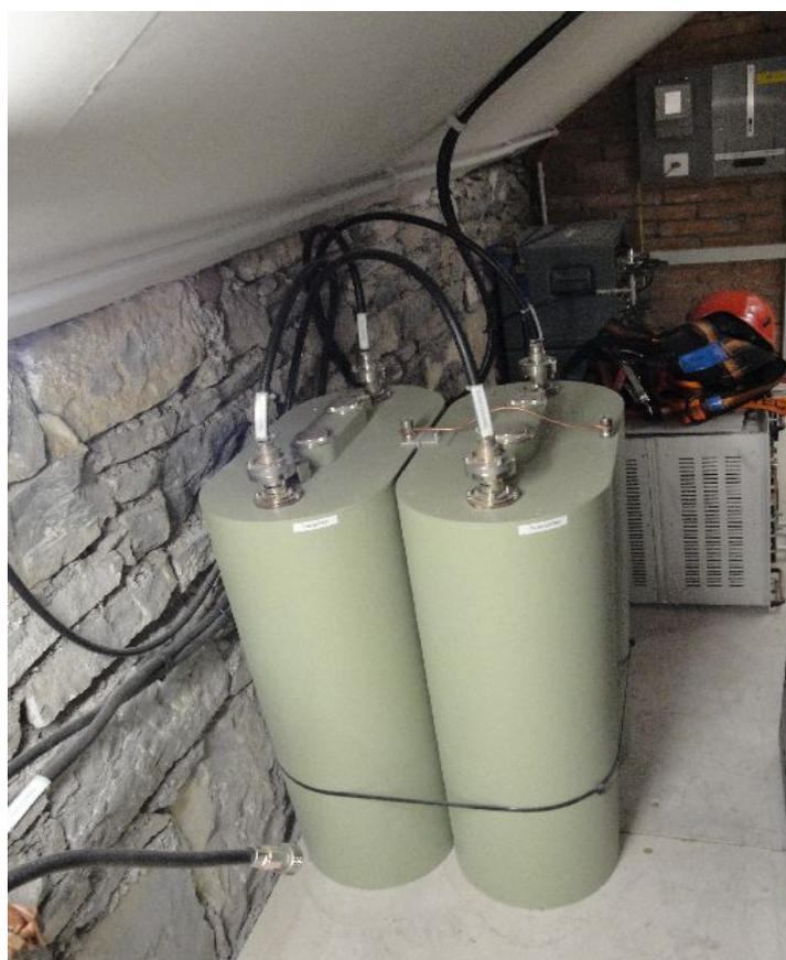
Abbildung 3: Die Filter des Radio BeO sind schon etwas grösser (ausgelegt für 1KW Sendeleistung)
