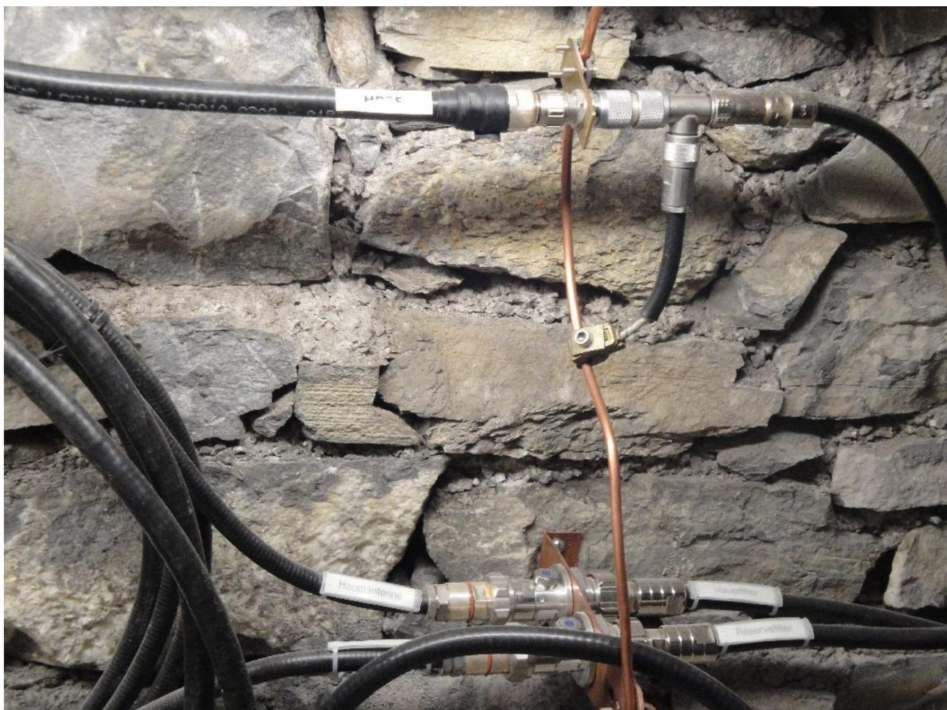
*Abbildung 1: Detail des (zweiten) Blitzschutzes mit Lambda/4 Stub*
