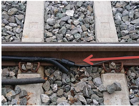
Übergang Einspeisung – Leckkabel (hier mit 2 Klapp-Ferriten, ohne Schutz)
